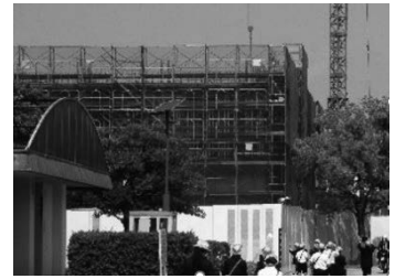
【資料6 建設中の雨水ポンプ場を見る子ども】
